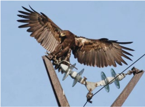
Большой подорлик на ЛЭП. Фото С.В. Павлова
