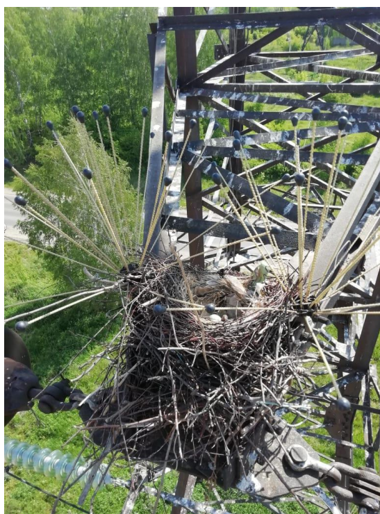
Рис. 1-3 – Пример успешного гнездования птиц на опоре, оснащённой неэффективными АПЗУ типа «Ёж»
