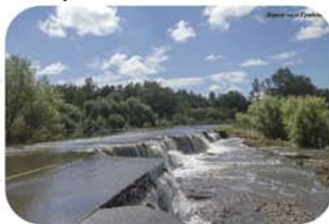
Дороги вокруг парка были разрушены дождями. Фото В. Дугинцова
