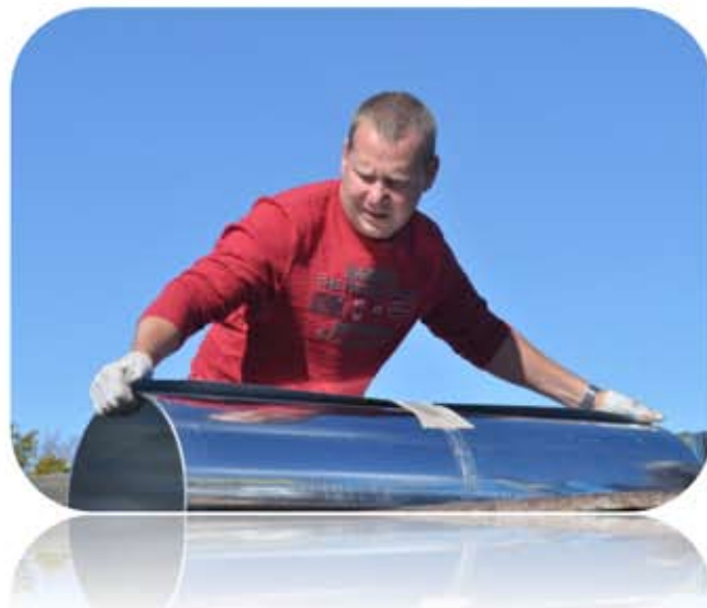
Алексей Яценко привез в парк для крыши зернохранилища грузовую машину оцинкованного железа, приобретенного его семьей
